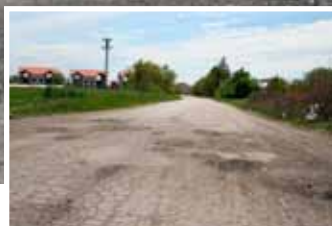
Stratul asfaltic de pe strada a II-a va fi refăcut
